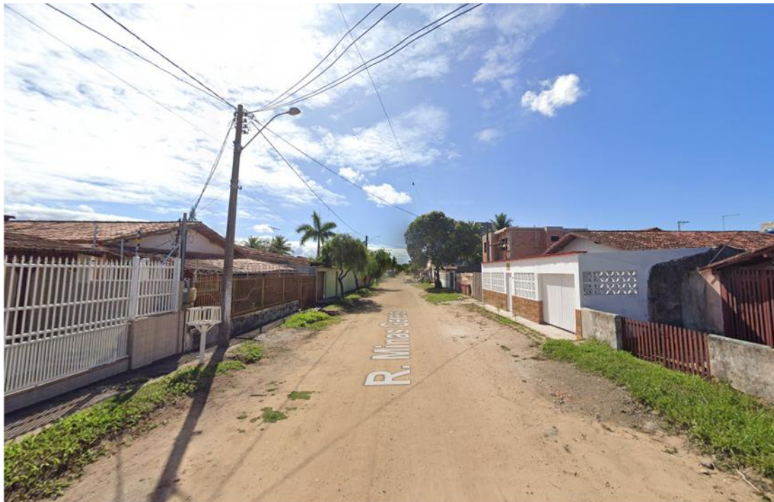
Figura 55 – Ausência de Acessibilidade na calçada na R. Minas Gerais – Praia Grande
