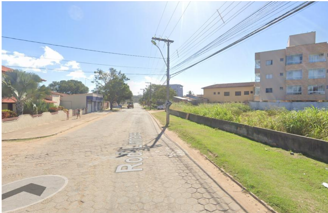
Figura 54 – Ausência de Acessibilidade na calçada na Rod. Linhares – Praia Grande
