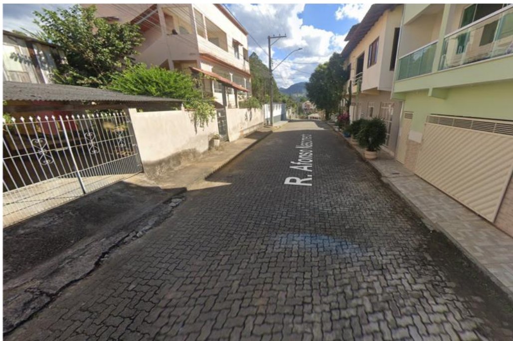
Figura 50 – Ausência de Acessibilidade na calçada na R. Afonso Nascimento
