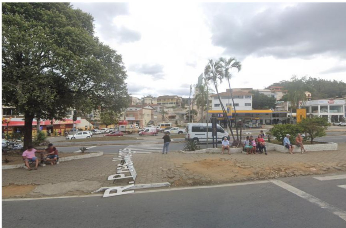
Figura 48 – Ausência de Acessibilidade na calçada na R. Everaldo Silva
