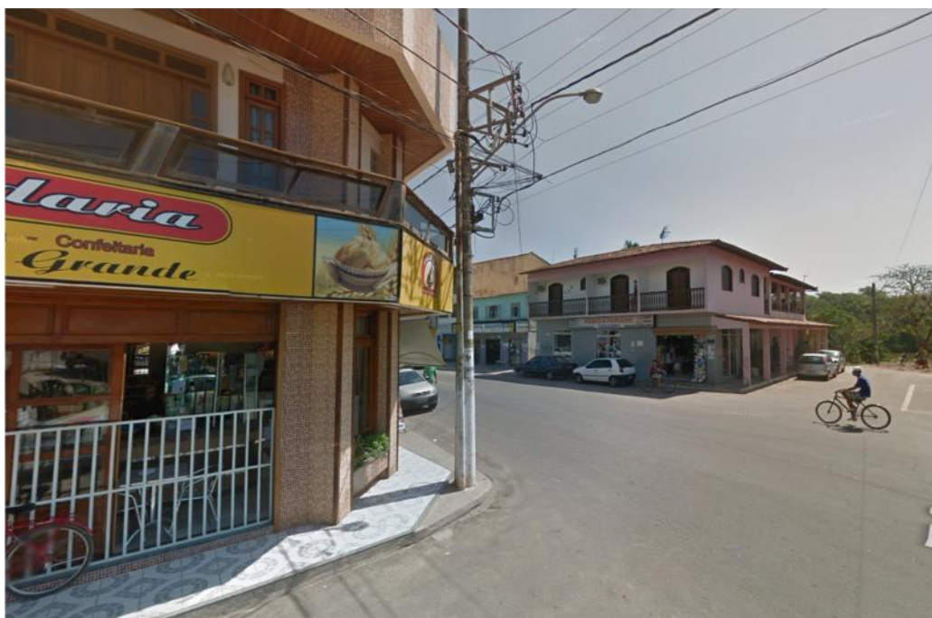
Figura 53 – Ausência de Acessibilidade na calçada na R. Nossa Sra. Das Graças, Praia Grande
