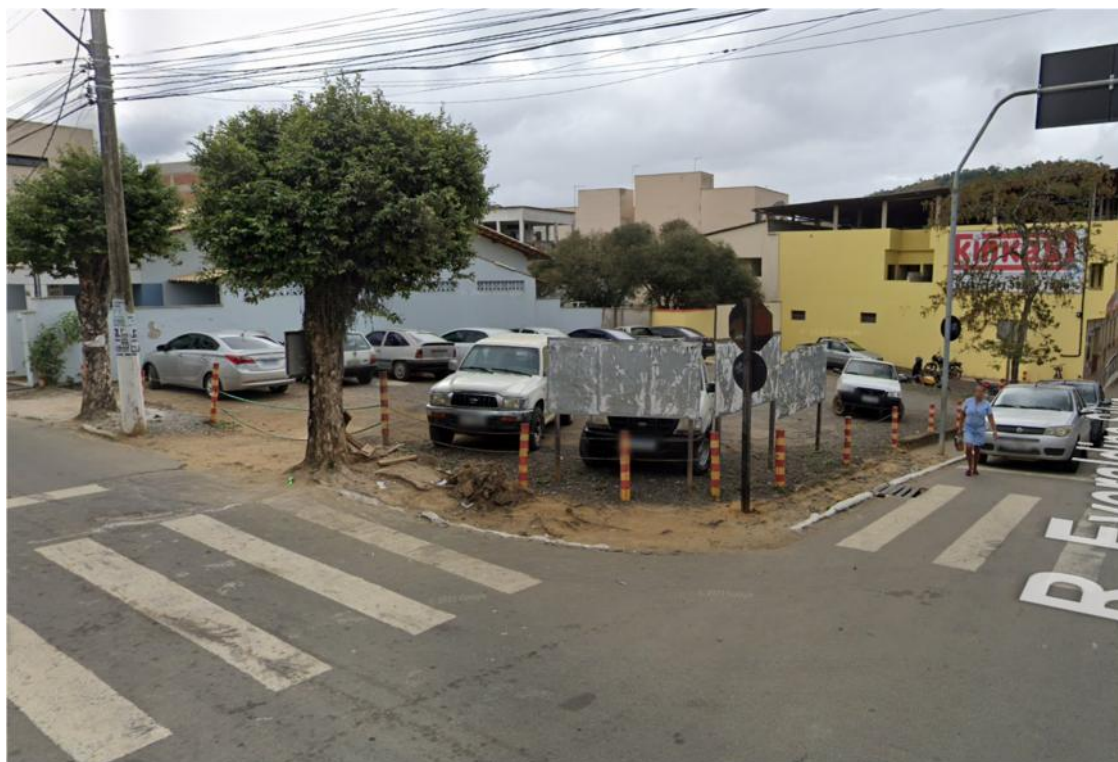
Figura 47 – Ausência de Acessibilidade na calçada na R. Everaldo Silva
