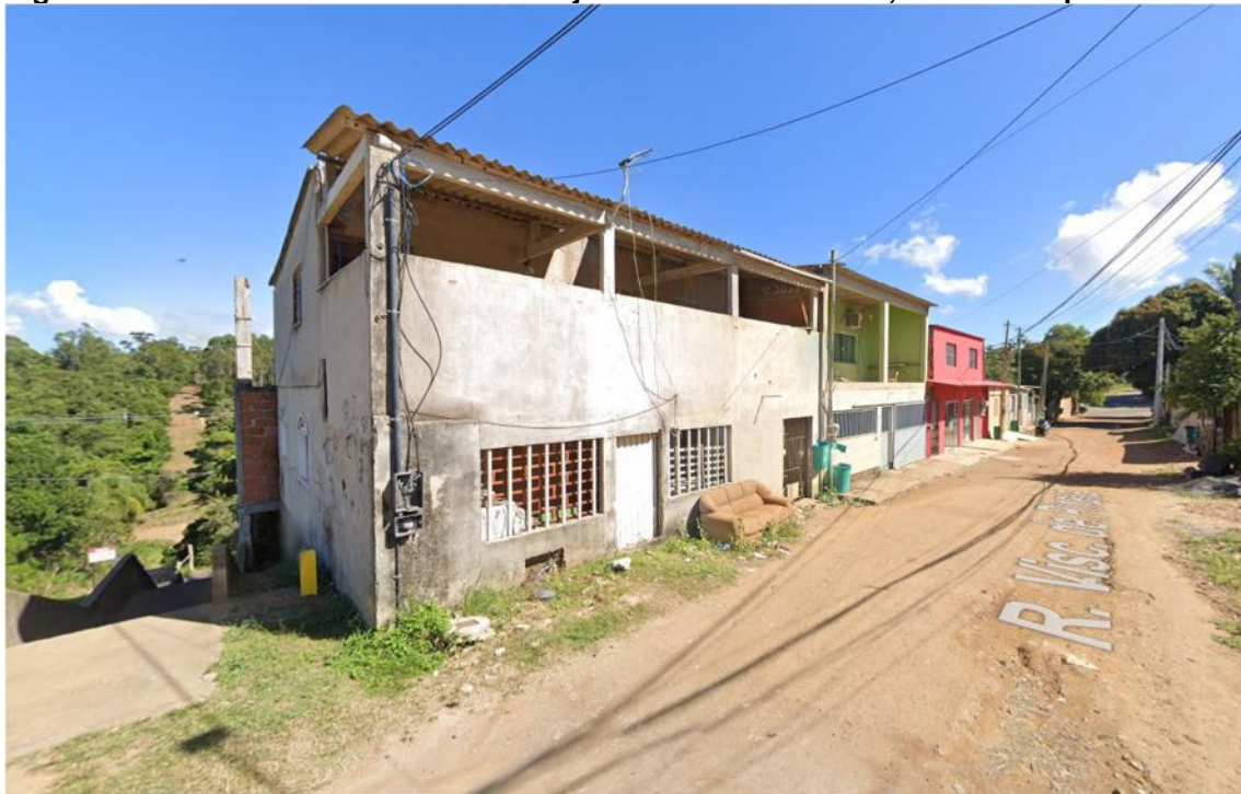
Figura 14- Vista da Rua Visconde de Pirajá – Casas com reboco, com e sem pintura
