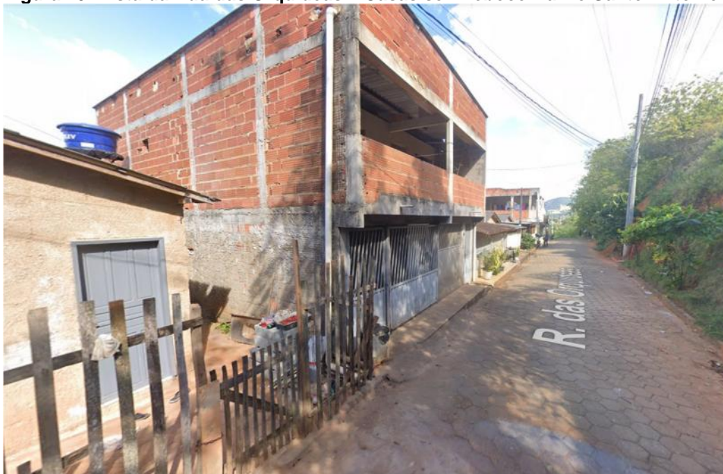
Figura 10- Vista da Rua das Orquídeas – Casas sem reboco Bairro Santo Antônio
