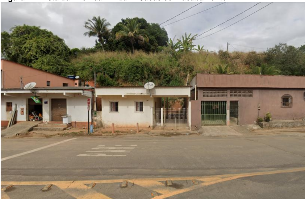
Figura 12- Vista da Avenida Timbuí – Casas com acabamento
